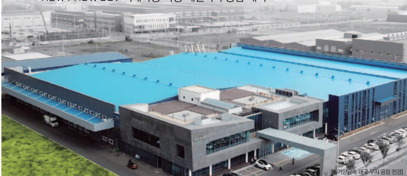
[거양금속 대구 구지 공장 전경]
